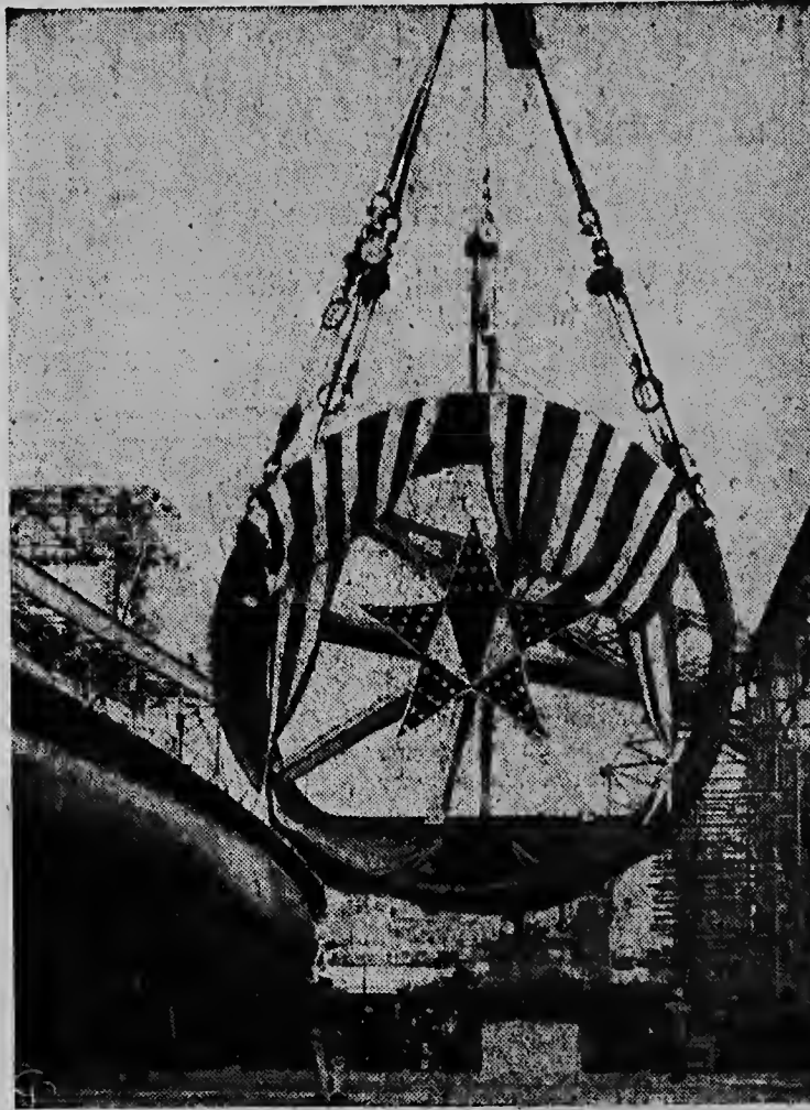
De met vlaggen versierde cirkel is het 40 ton wegende midden gedeelte van de nieuwste atoom-duikboot Sargo. Dit schip (links) is de eerste atoomonderzeeer ter wereld. Rechts is de tweede in aanbouw, die Grayback genoemd zal worden.
